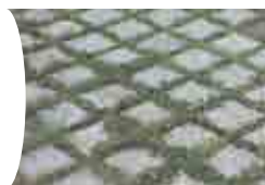
■ Pavés béton avec joints larges
