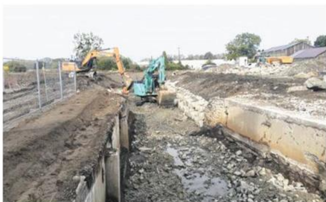
Afin de faciliter le chantier, le Guyoult a été asséché après la déviation de son cours dans le ruisseau des Tendières.
