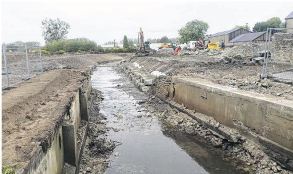
Le Guyoult va retrouver un cours plus naturel dans le quartier des Tanneries.
