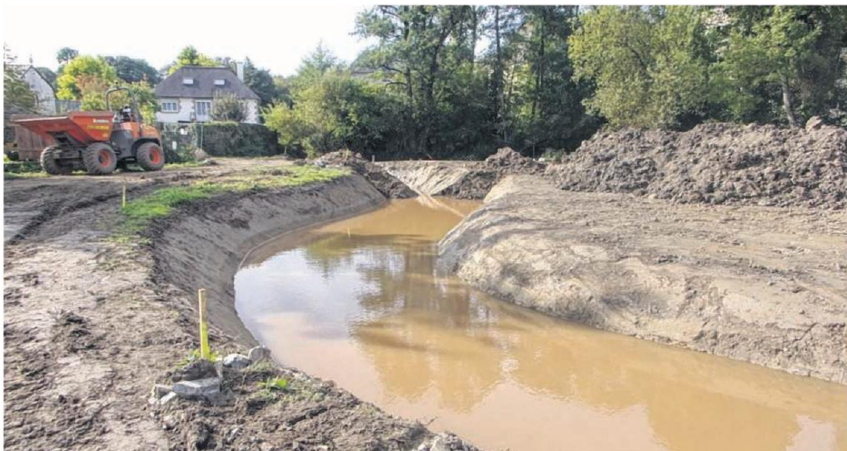
Le cours du Guyoult est modifié par ces travaux, lesquels sont financés à hauteur de 80% par l'Agence de l'Eau Loire-Bretagne et de 20% par le SBCDol.
